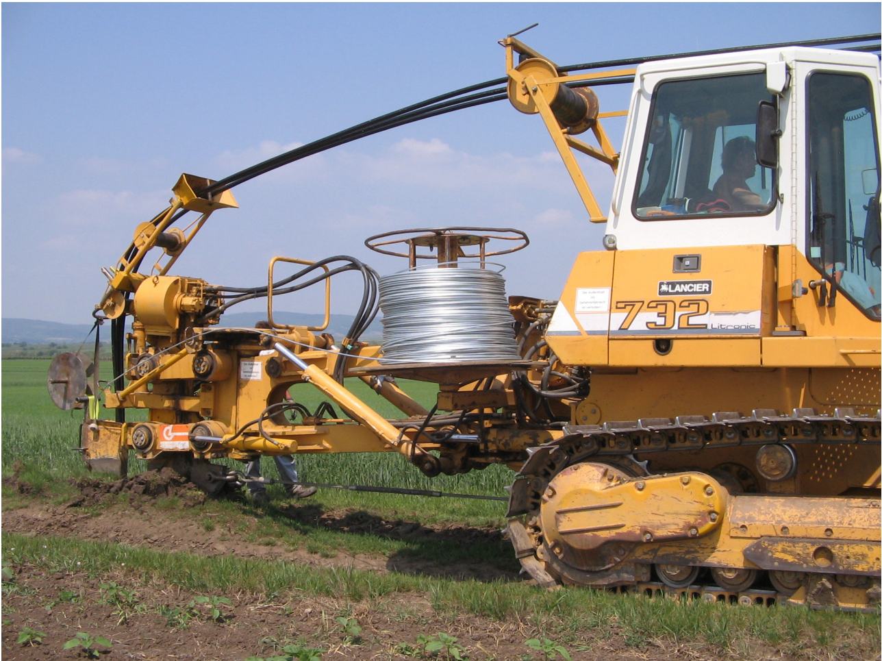
Abb. 4: Pflügearbeiten für die Erdverkabelung der EVN 20 kV Leitungen Westliches Weinviertel im Juni 2007 (Foto: S. Raab) - transferring medium voltage power lines below the soil.
