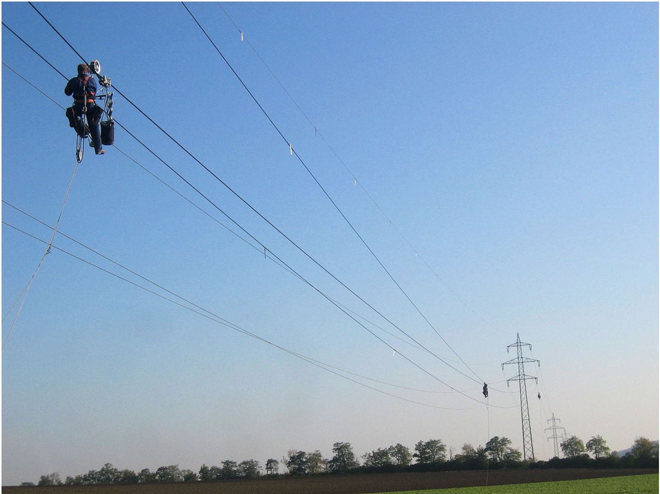
Abb. 6: Markierung der EVN 110 kV Leitungen Westliches Weinviertel am 5. Dezember 2007 (Foto: EVN) - marking of power lines.
