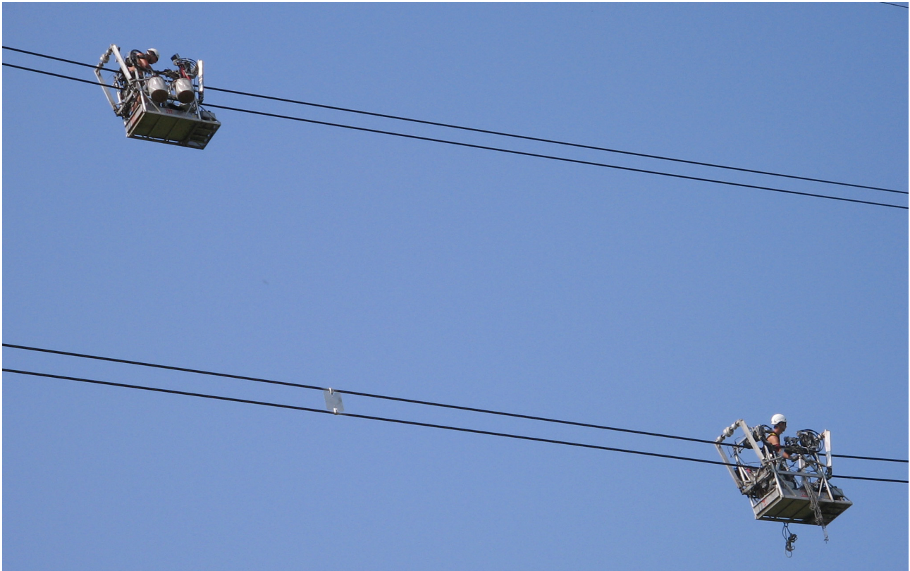
Abb. 11: Markierung der Verbund APG 380 kV Leitungen Parndorfer Platte – Heideboden im Juli 2006 (Foto: R. Raab) - marking of power lines.
