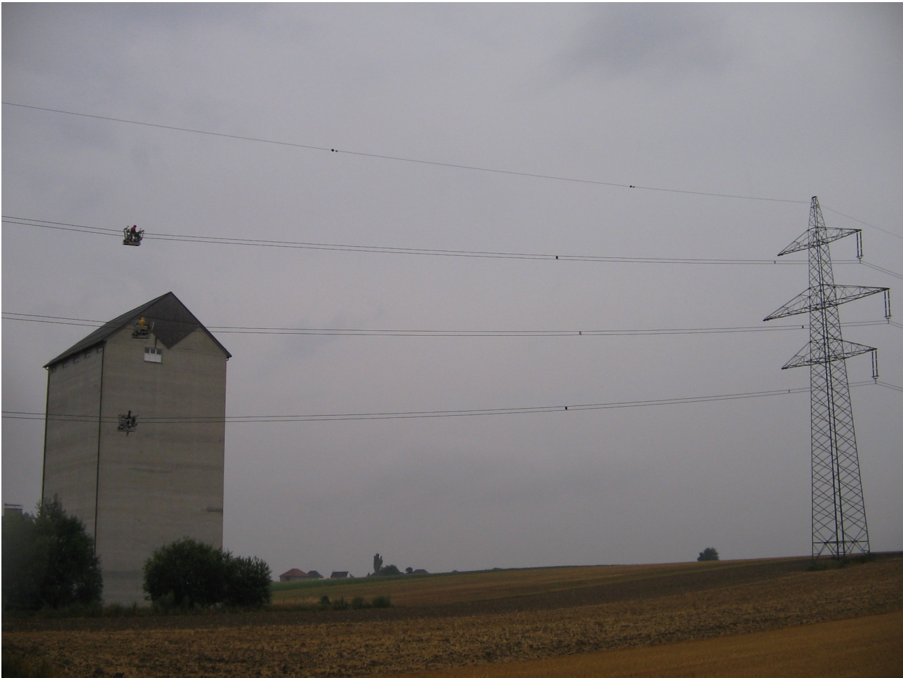
Abb. 7: Markierung der Verbund APG 380 kV Leitungen Westliches Weinviertel im August 2006 (Foto: R. Raab) - marking of power lines.
