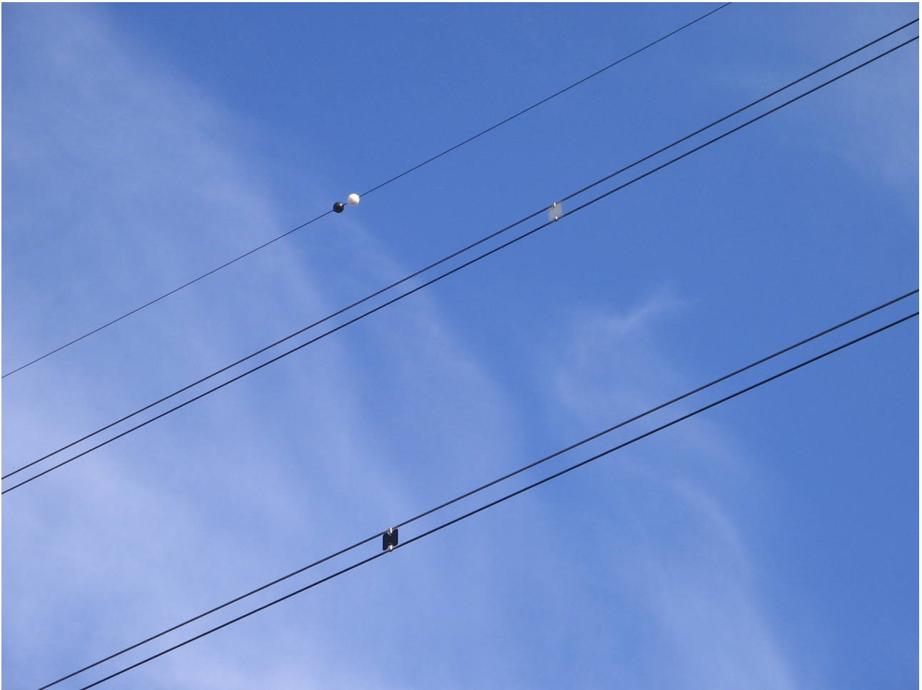
Abb. 3: „Vogelwarnkugeln“ (Durchmesser 30 cm) aus Kunststoff (für Erdseil) und „Vogelwarntafeln“ (ca. 30x30 cm) aus Aluminium (Foto: R. Raab) - “bird warning balls“ and “bird warning plates“.
