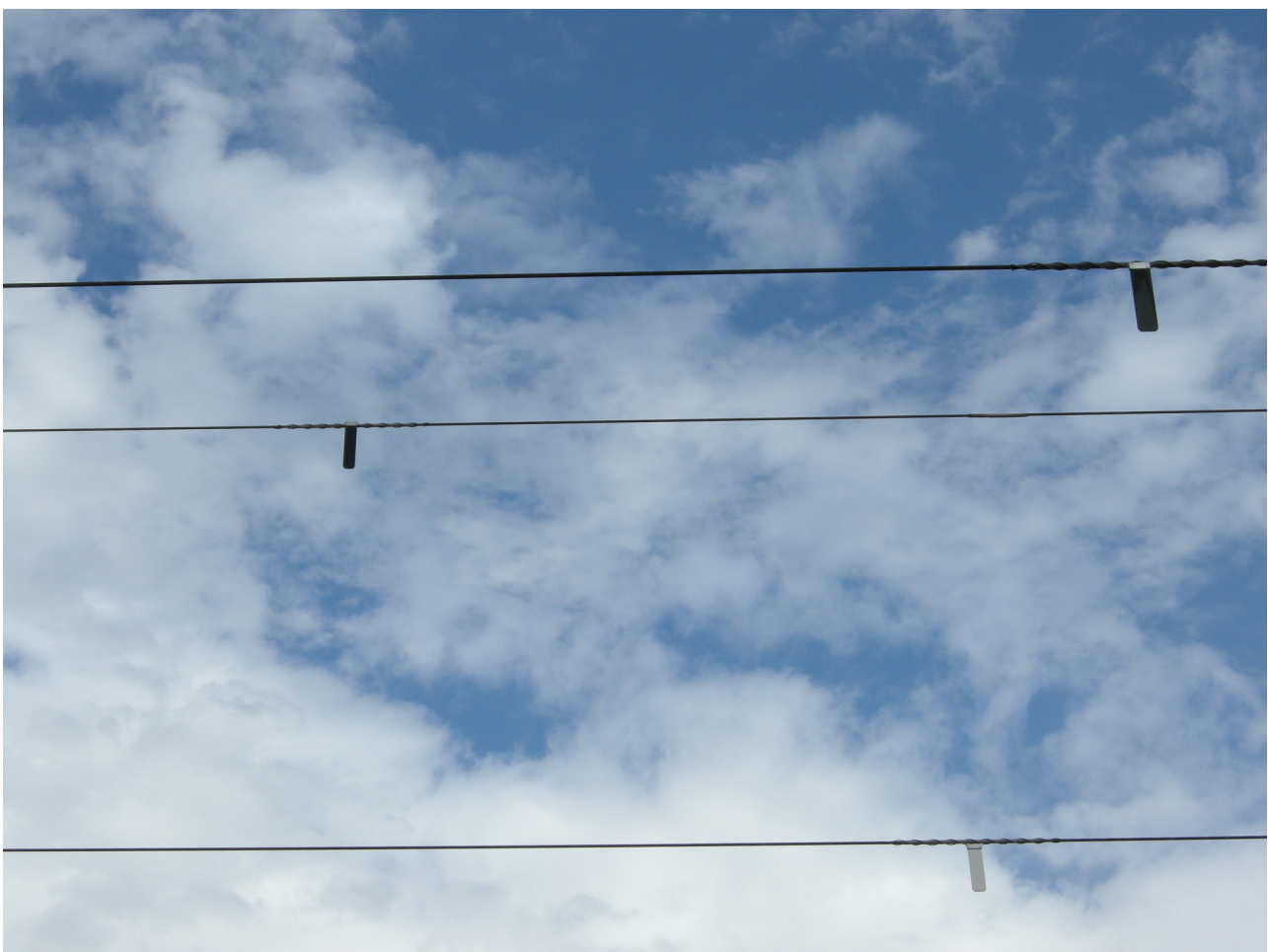
Abb. 8: Mit schwarzen und weißen „Vogelwarnfahnen“ markierte Leiterseile, die von 20. August 2007 bis 14. September 2007 markiert (vorerst nur die vier Leiterseile) ÖBB 110 kV Leitungen Westliches Weinviertel (Foto: R. Raab, 20. Juli 2008) - marked power lines.
