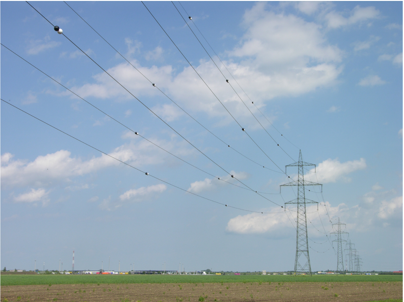
Abb. 10: Markierte Verbund APG 220 kV Leitungen Parndorfer Platte – Heideboden im Mai 2007 (Foto: E. Julius) - marked power lines.
