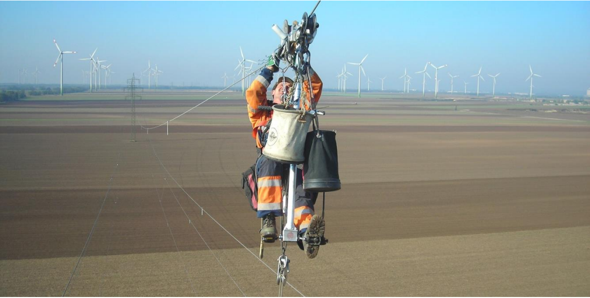
Markierung von Hochspannungsleitungen mit Vogelwarnfahnen im Projekt - Teilgebiet Parndorfer Platte - Heideboden.
